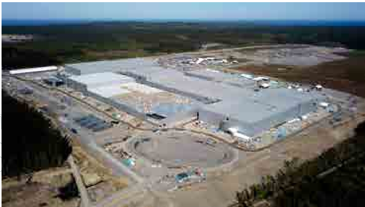
Рис. 1. Огромный завод по производству литий-ионных аккумуляторов Northvolt Ett на севере Швеции
