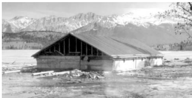
Рис. 2. Прототип авіаносця «Аввакум» в Канаді у вигляді плаваючого будинку
