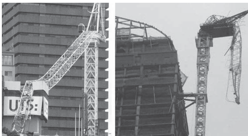
Рис. 4. Приклади аварій будівельних баштових кранів, що сталися через обрив стрілового каната
