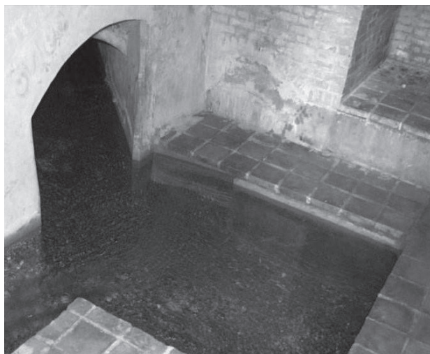
Рис. 9. Подземная водоносная галерея кяризной системы
