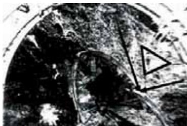
Рис. 2. Втрата стійкості реальної гірничої виробки, що супроводжується формуванням «клин втискування» з утворенням ядра перем'ятих ущільнених порід
