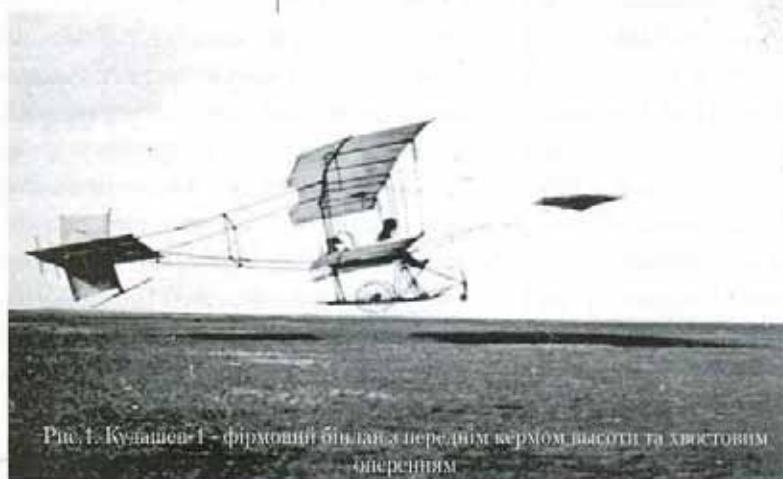
Рис. 1. Кудашев-1 – фірмовий білан з переднім кермом висоти та хвостовим оперенням
