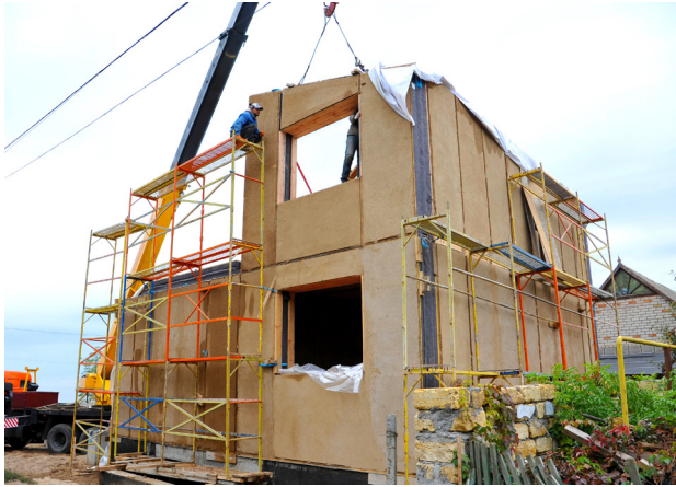
Рис. 2. Монтаж стінових панелей
