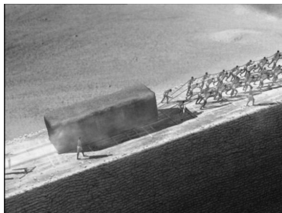
Рис. 10. Транспортировка массивных гранитных блоков для строительства пирамид.
