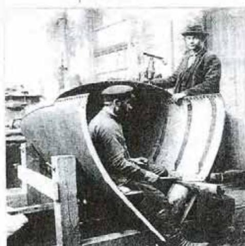
Рис. 6. Строительство подводной лодки Джевецкого
